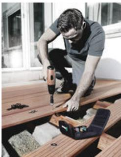
Bit-Halter zum gleichmäßig bündigen Versenken von Schrauben in Holzdielen beim Terrassenbau
